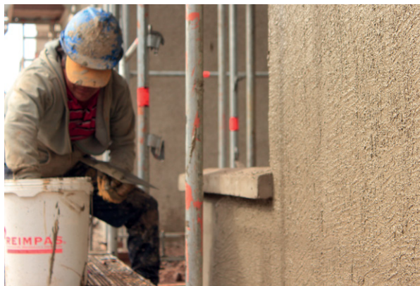
Aplicación Estucryl en Obra de Constructora Pocuro.
